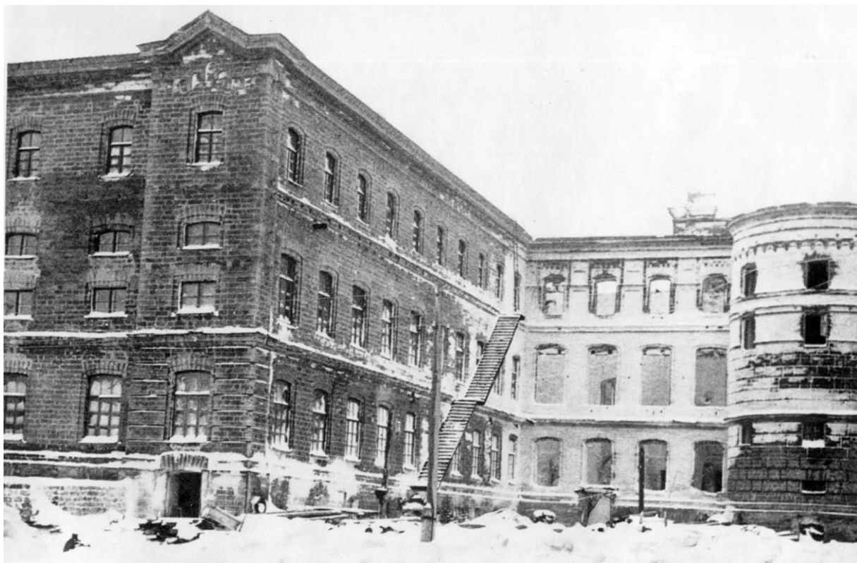
Разрушенное здание Сельскохозяйственного института.
